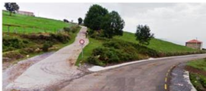
Cruce de la carretera con la pista hormigonada
