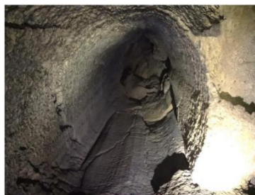
Chimenea en resalte 4 m
